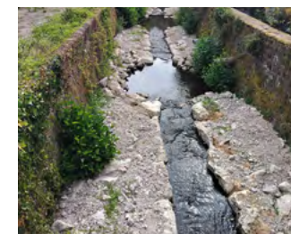
Exemple de restauration de la continuité écologique au niveau de l'ancien seuil dit "du restaurant Errard". La libre circulation des poissons et des sédiments a été rétablie. Des banquettes minérales ont été créées pour maintenir la répartition des écoulements entre le cours principal et le bras de la rue Anne de Bretagne.
